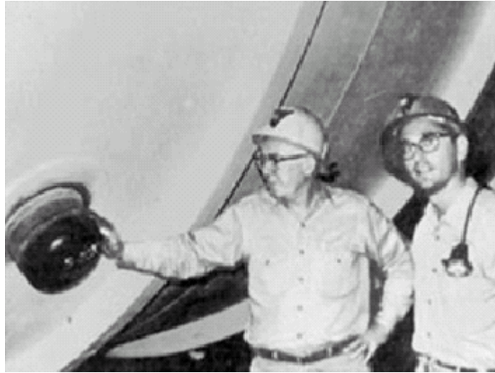
Reymond David Jr. (sinistra) e John Bacall in abbigliamento da minatori e casco protettivo. Foto scattata nel 1967 in una miniera nel South Dekota, USA. Davis mostra a Bachall il suo nuovo serbatoio in acciaio (6 metri di diametro, 15 metri di lunghezza) contenente 40.000 litri di fluido detergente usato per catturare i neutrini del sole.
